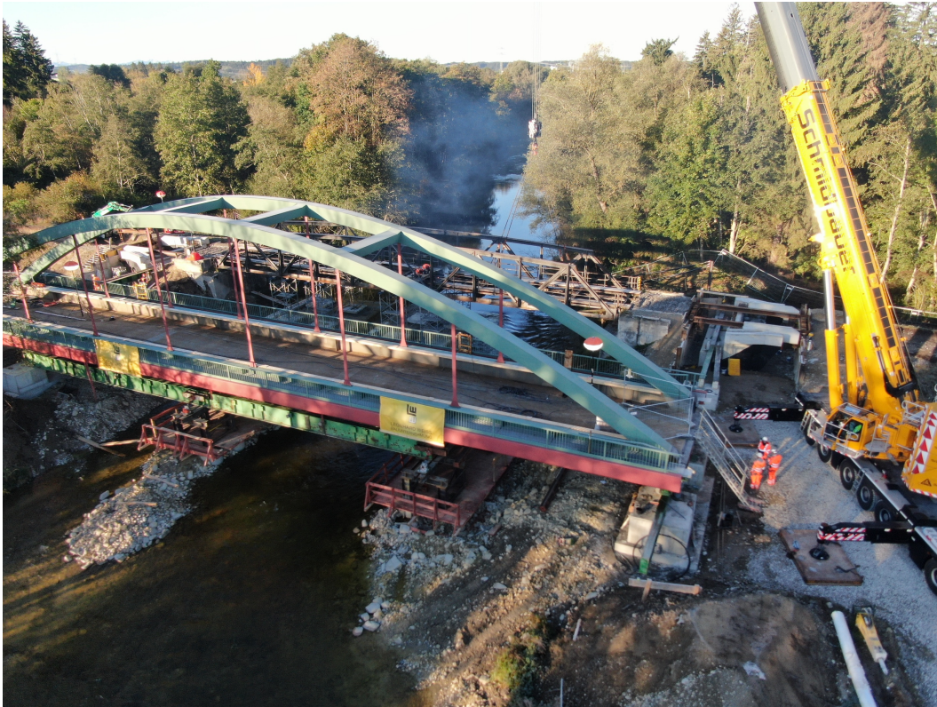
2021 Wertach – Stabbogenbrücke Quer-/Längsverschub / Foto: Burkhardt Walter
