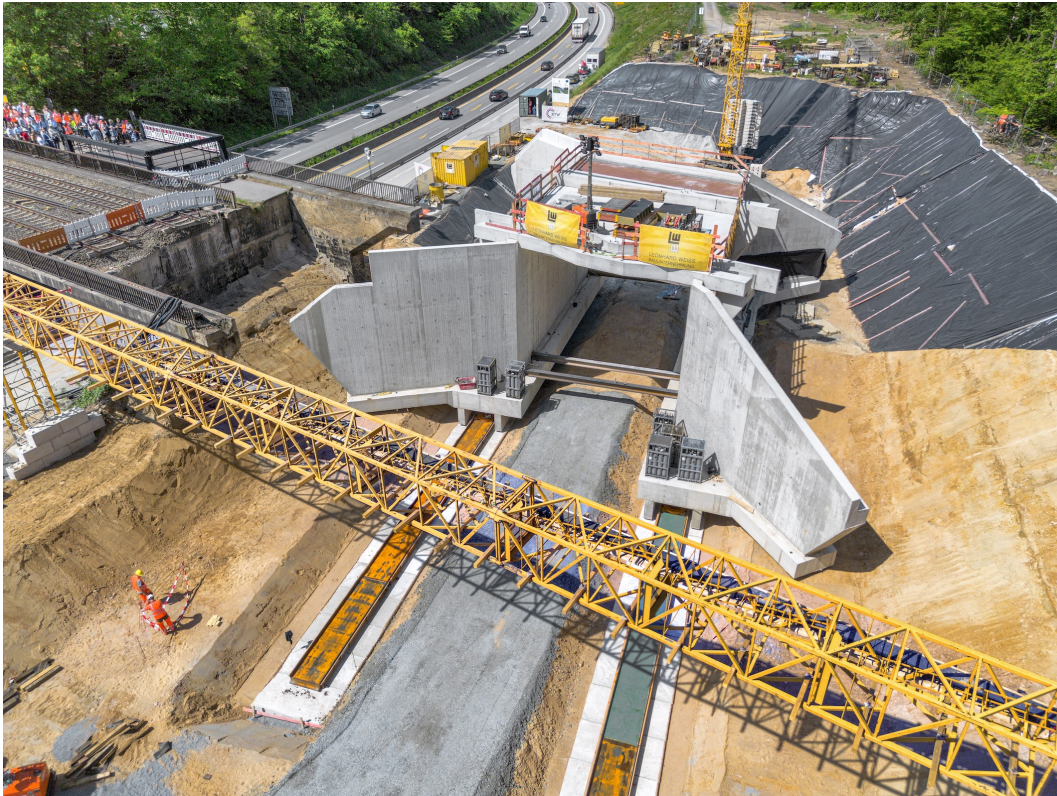
2025 Kelsterbach-Hinkelstein – Brückenverschub; Bauvorhaben Regionaltangente West / Foto: Michael Thomas Wolff
